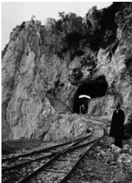
Foto degli scavi del costone roccioso per la realizzazione di una terza galleria, da T. CIVIDINI, SS. 14 "Della Venezia Giulia", Note Storiche, Fvg strade, 2021
