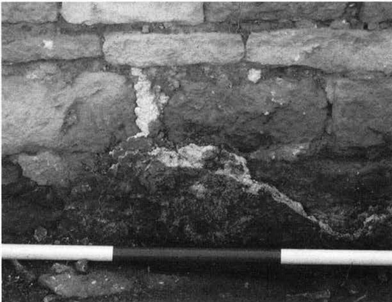
Fig. 11 – Visola, Medolino - Dettagli di intonaco nel corridoio nord-est
