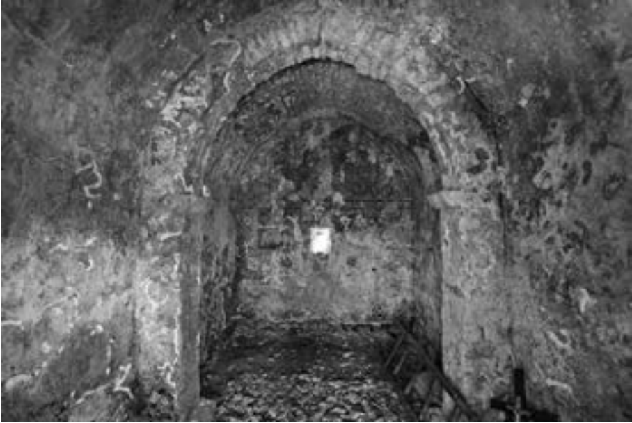
Foto 9 – San Matteo: interno con i pilastrini laterali e la volta a botte (2010; foto di Silvano Toffoletti)
