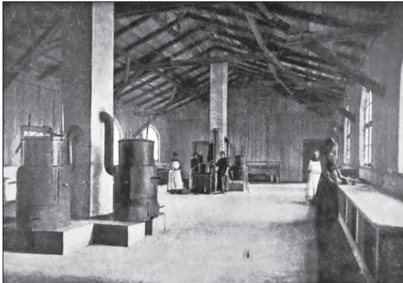
Fig. 76) La cucina dell'asilo infantile / Kuhinja dječjeg vrtića.
