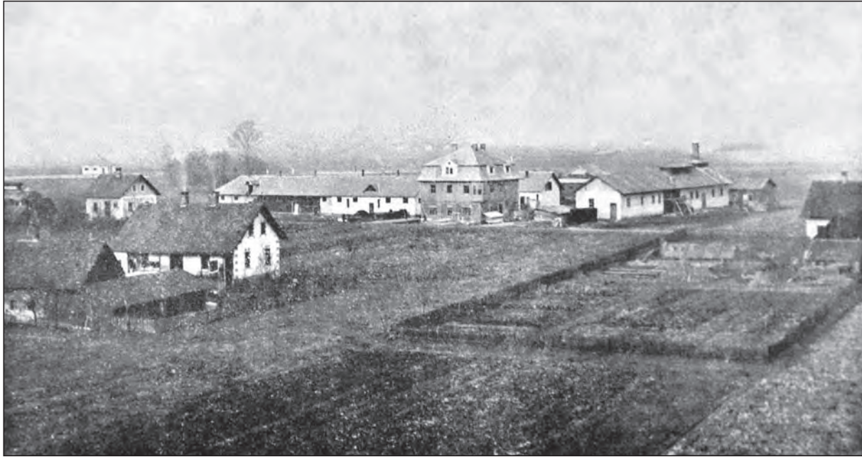
Fig. 113) Edifici “economici”, macello, stalle / Gospodarski objekti, klaonica, štale .
