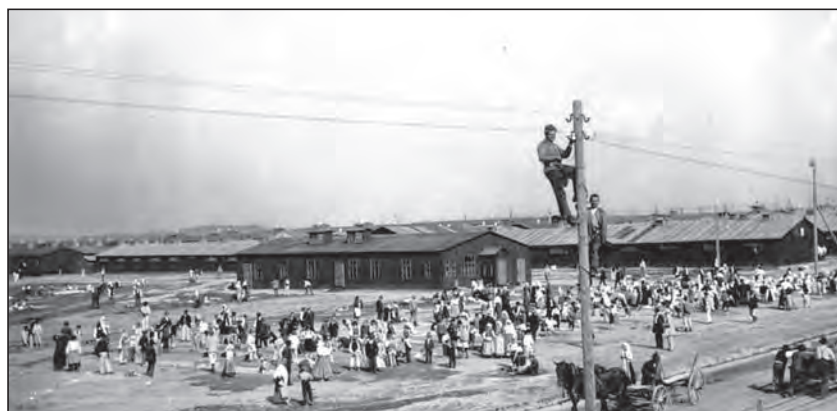
Fig. 16c) I lavori sulla rete dell'elettrodistribuzione / Radovi na mreži elektrodistribucije.
