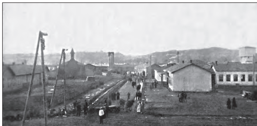
Fig. 16b) Il canale per la canalizzazione scavato, si vedono la cappella, la torre dei pompieri e la scuola di cucito / Iskopan kanal za kanalizaciju, vide se kapelica, vatrogasni toranj i škola šivanja.
