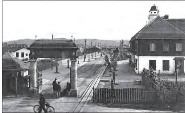
Fig. 85b) L'entrata e l'Amministrazione, veduta dall'entrata nell'accampamento / Ulazna vrata i Uprava, pogled sa ulaza u logor.
