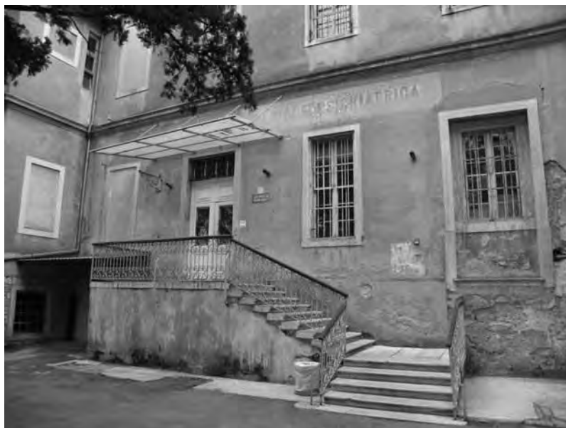
L'entrata alla sezione psichiatrica oggi con ancora ben visibile la vecchia scritta sulla facciata.
