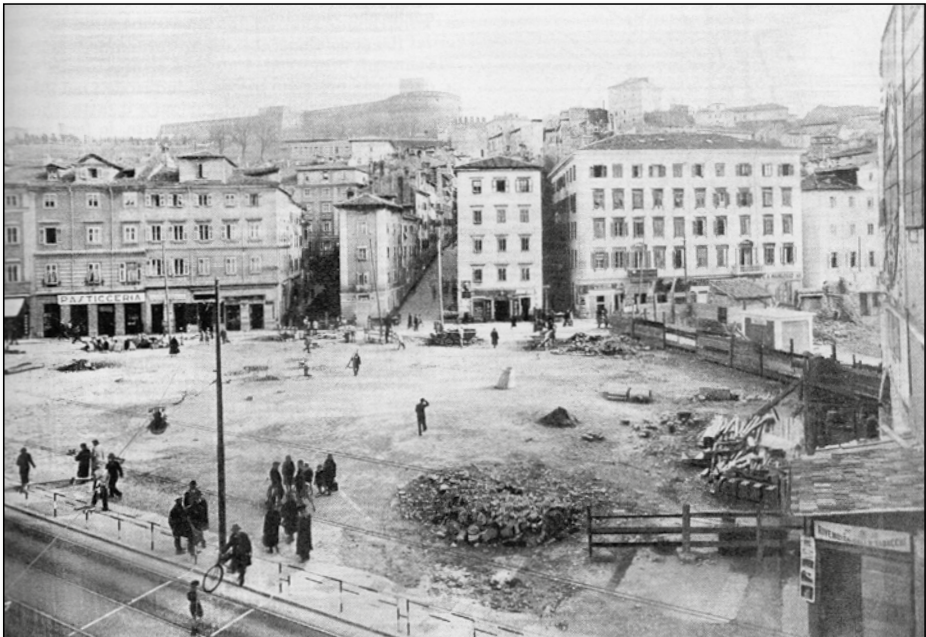
La nuova piazza Malta ottenuta dalle demolizioni presso il Corso (da Opere Pubbliche, a cura del Ministero LL.PP, 1935)
