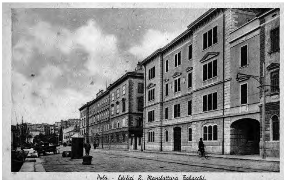
Pola - Edifici R. Manifattura Tabacchi.
