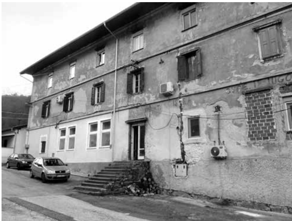
L'edificio che ospitava l'asilo e la scuola elementare di Carpano, oggi suddiviso in unità abitative.
