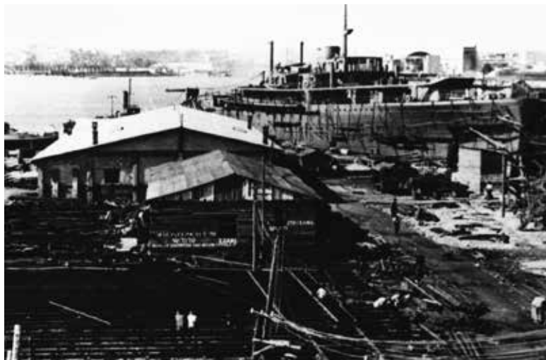
La nave Vladimir Nazor in costruzione sullo scalo di alaggio, 1952 (Collezione M. Rabota)
