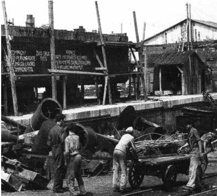
Cantierini Scogliolini e ferramenta con scritte inneggianti alla resistenza contro i cominformisti. La parte in lingua croata dice: "Lavoratori! I cominformisti hanno l'intenzione di ostacolare la costruzione socialista e di trascinarvi sulla strada sbagliata" (Collezione M. Rabota)
